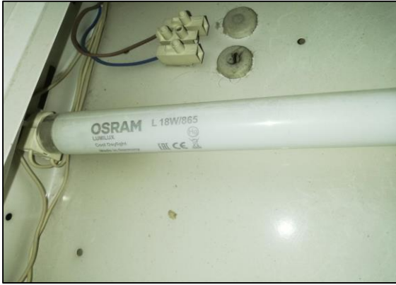
Şekil 2. Değişim öncesi tespit çalışmaları.
